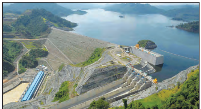
Empangan Bakun, Sarawak
