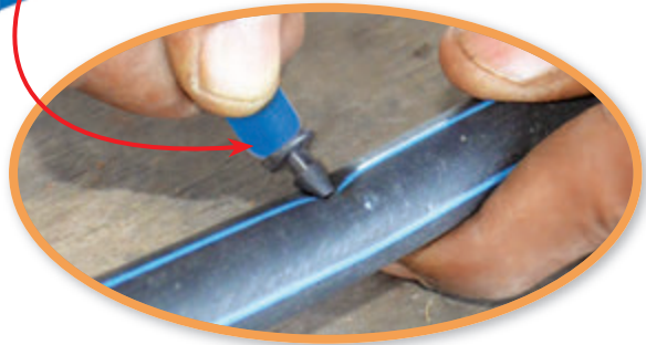
Gambar foto 5.13 Penyambungan paip tertier pada set penitis
