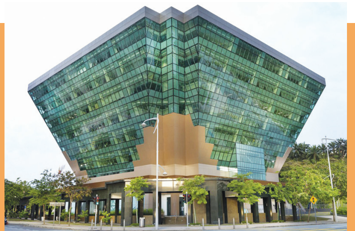
Bangunan Berlian Suruhanjaya Tenaga Malaysia di Putrajaya merupakan bangunan hijau
