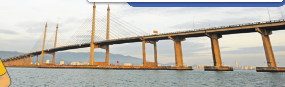
Jambatan Pulau Pinang
