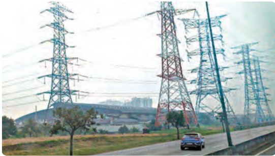
Kabel penghantaran arus ulang-alik pada 500 kV di sepanjang Lebuh Raya Utara-Selatan.
