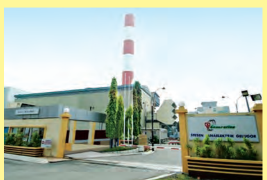
Stesen jana kuasa Gelugor di Pulau Pinang (Sumber tenaga: Diesel)
