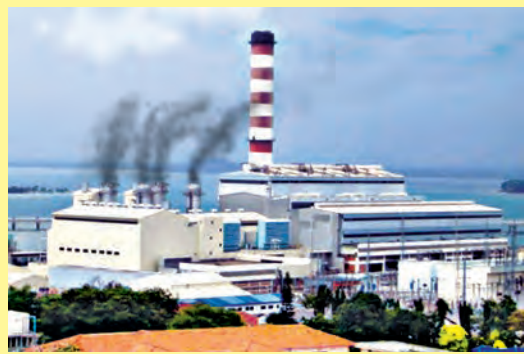
Stesen jana kuasa Tuanku Jaafar di Negeri Sembilan (Sumber tenaga: Gas asli)
