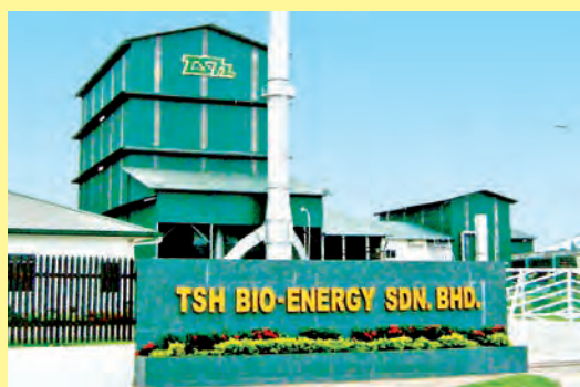
Stesen jana kuasa biojisim TSH Bio-Energy Sdn. Bhd. di Sabah (Sumber tenaga: Biojisim)
