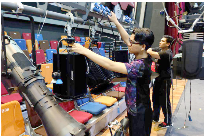
Gambar Foto 3.6 Proses memasang lampu pada lighting bar .
