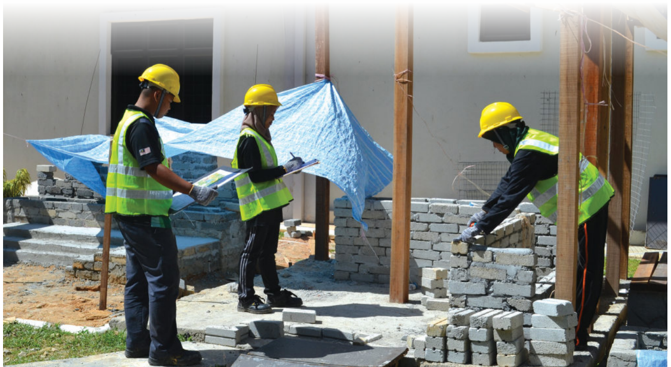
Foto 5.63: Mengesahkan struktur yang hendak dibina.
