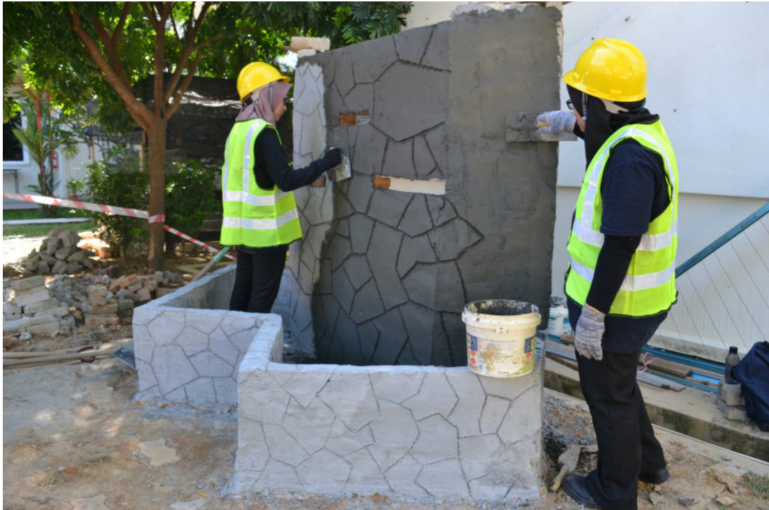
Foto 5.21: Aktiviti melepa Morta pada binaan landskap kejur.
