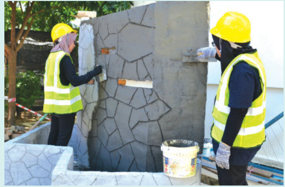
Foto 6.17: Melepa semula struktur landskap kejur yang rosak.
