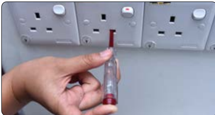
Foto 2.2 Menguji punca Hidup pada soket alir keluar
