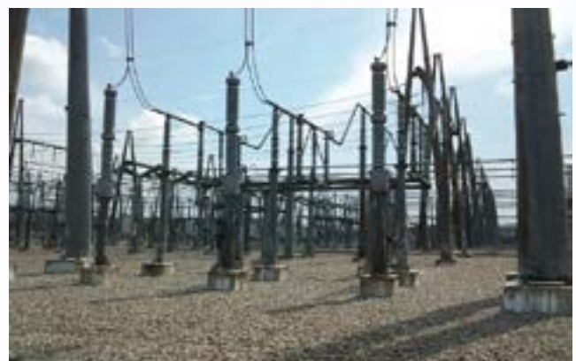
Foto 4.1 Pencawang milik Tenaga Nasional Berhad (TNB) yang menempatkan pengubah kuasa perendah bagi menurunkan nilai voltan
