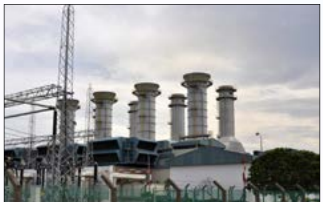
Stesen Janakuasa Gas Asli di Paka, Terengganu
