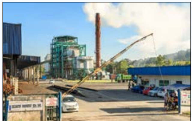
Stesen Janakuasa Biomass di Sandakan, Sabah
