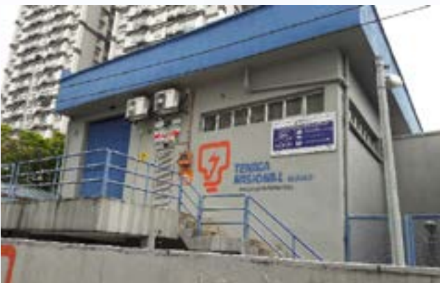
Foto 4.1 Pencawang milik Tenaga Nasional Berhad (TNB) yang menempatkan pengubah kuasa perendah bagi menurunkan nilai voltan
