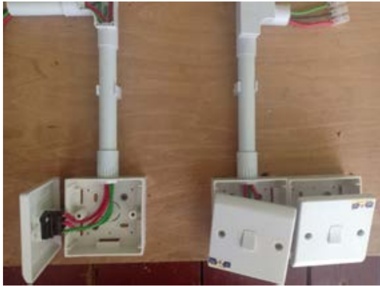
Pemasangan kabel Hidup pada tamatan suis
