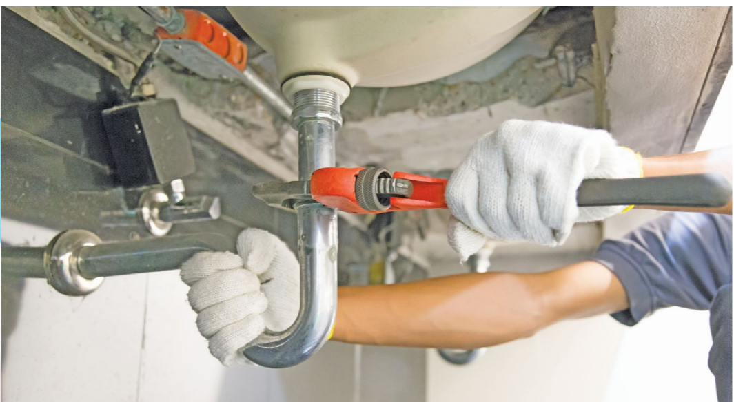
Gambar 2.7 Penggunaan peralatan yang betul akan memudahkan kerja pembaikan dan pemasangan paip
