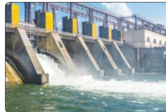
Foto 1.1 Stesen jana kuasa tenaga elektrik.
