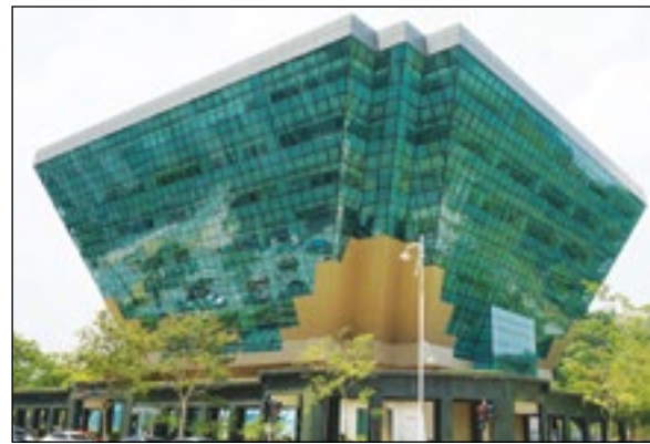
Foto 1.8 Bangunan Berlian Suruhanjaya Tenaga
