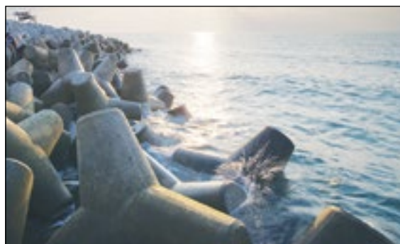
Foto 2.6 Pemecah ombak yang menggunakan konkrit jisim
