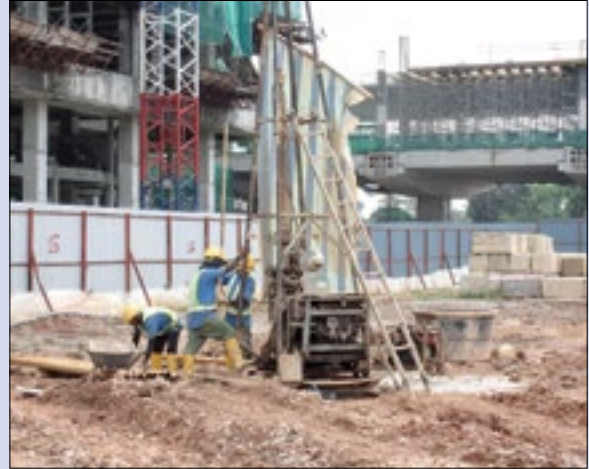
Foto 3.1 Penyiasatan tapak pembinaan
