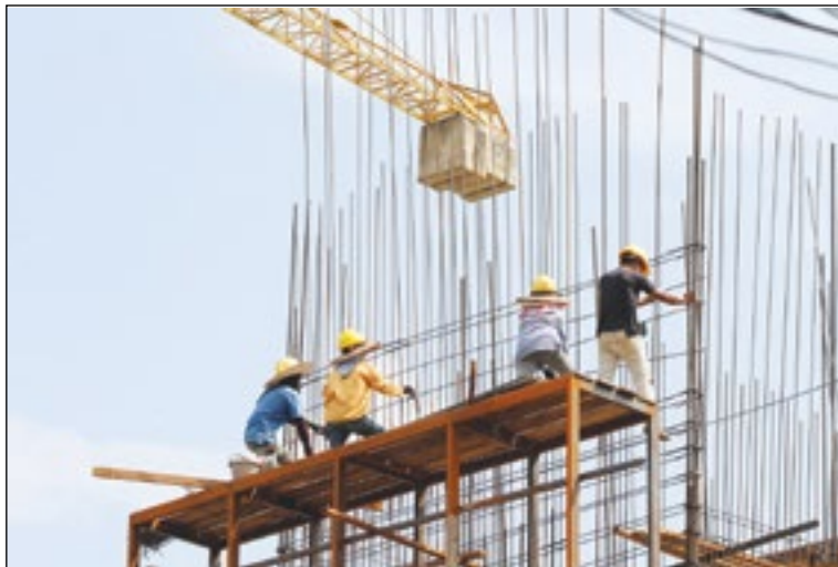
Foto 1.19 Pekerja di tapak bina
