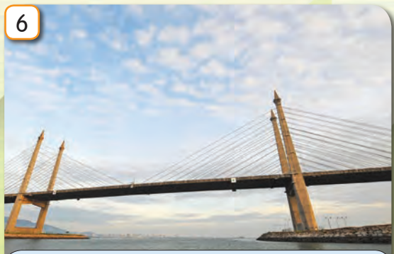
Jambatan Pulau Pinang
