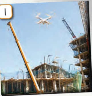
Kerja penyelenggaraan berisiko tinggi
