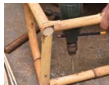
4 Tebuk lubang pada rangka rak dinding dengan menggunakan handrill .
