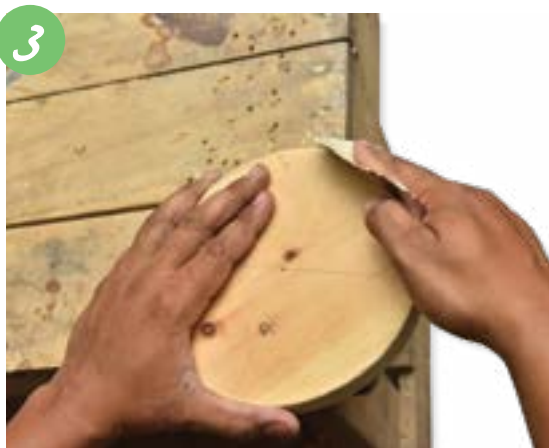
Licinkan muka jam yang telah dipotong dengan menggunakan kertas pasir.
