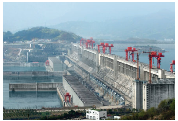
Empangan Tiga Gaung di Sungai Yangtze, China
