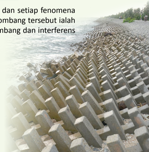
Gambar foto 6.5 Benteng di tepi pantai di Tanjung Piandang, Perak
