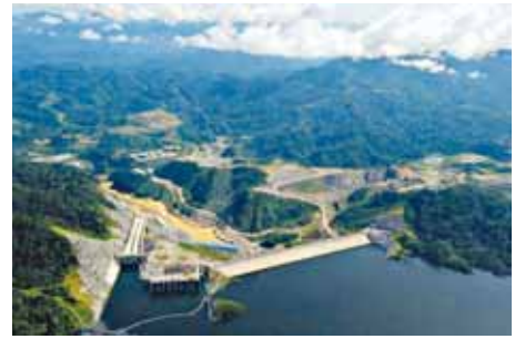
Gambar foto 3.5 Stesen jana kuasa hidroelektrik Bakun
