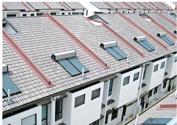
Gambar foto 3.2.2 Pemasangan panel solar di rumah
