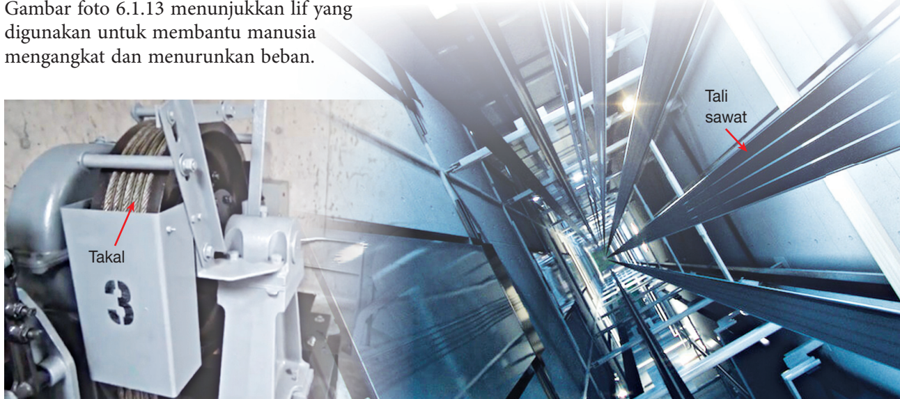
Gambar foto 6.1.13 Penggunaan takal dan tali sawat dalam sistem lif
