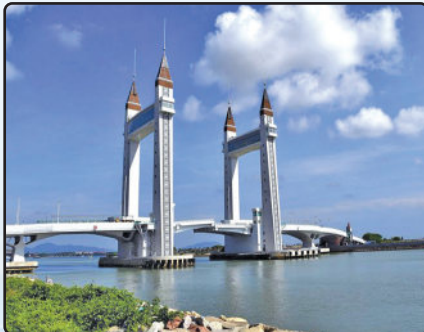
Jambatan Angkat Kuala Terengganu
