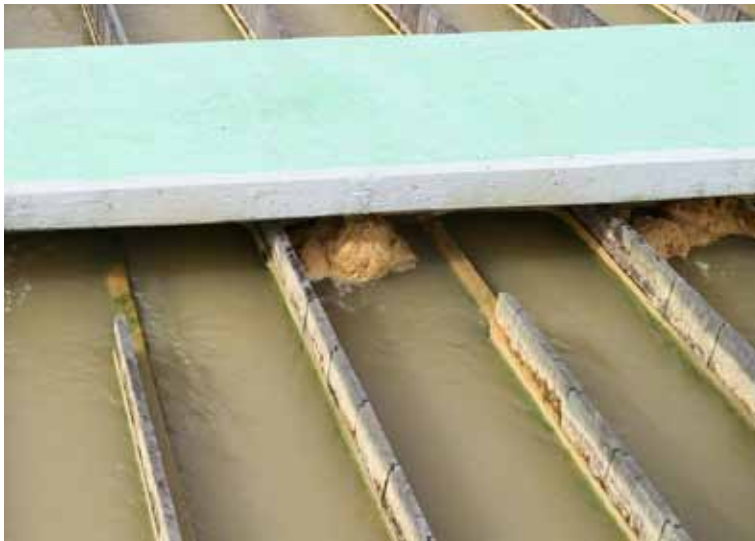
Foto 2.11 Flok yang terhasil daripada proses pengentalan dan penggumpalan
