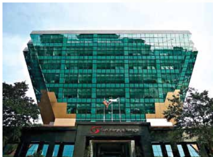
Foto 1.21 Bangunan Berlian Suruhanjaya Tenaga
