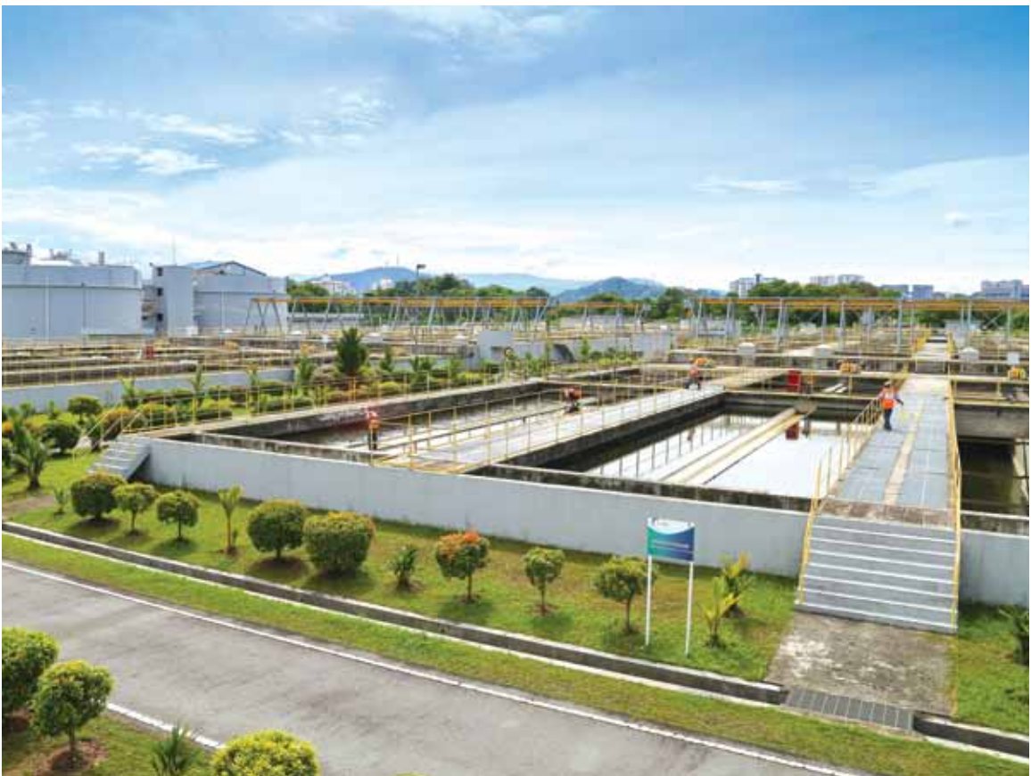
Foto 2.7 Loji rawatan air
