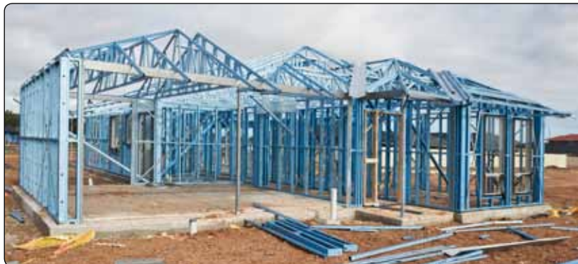
Foto 1.4 Sistem kerangka keluli
