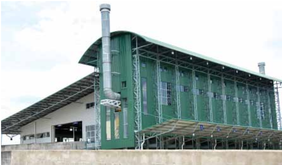
Foto 3.27 Stesen pemindahan sampah
