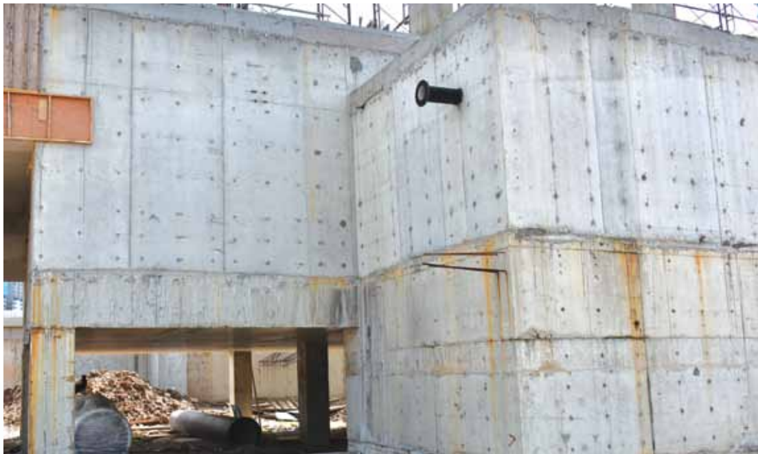
Foto 1.1 Dinding tanggung beban menggunakan kaedah tuang di situ
