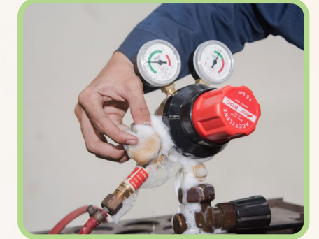
Foto 5.21 Menguji kebocoran pada penyambungan pada alatur Asetilena.
