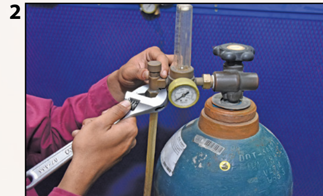
Memasang alatur dan meter alir pada silinder gas Argon dan menyambung hos pada mesin kimpalan TIG.
