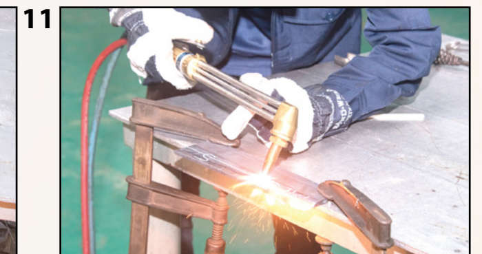
Gerakkan sumpitan api ke hadapan di sepanjang garisan pemotongan. Pastikan kelajuan yang digunakan sesuai mengikut ketebalan plat yang hendak dipotong.
