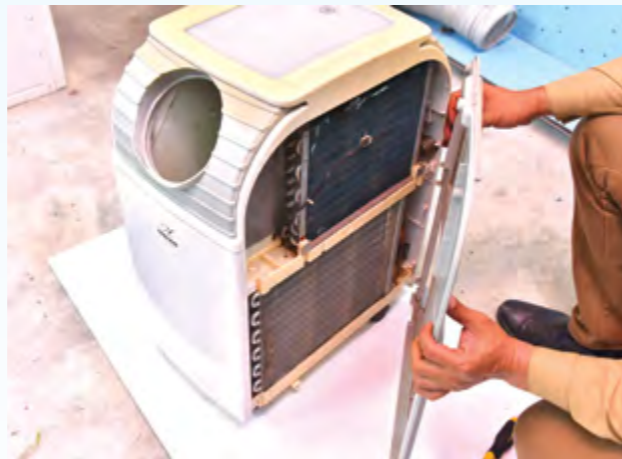
i. Buka unit penyaman udara mudah alih.
