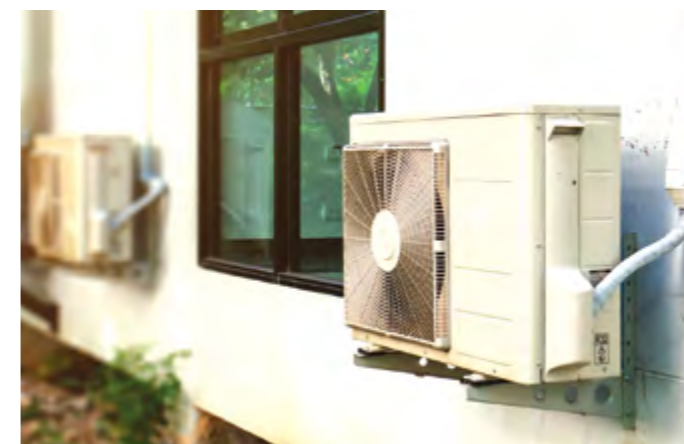
Foto 4.22 Saluran air keluar penyaman udara
