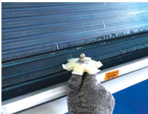
Foto 9.7 Kerja meluruskan sirip penyejat
