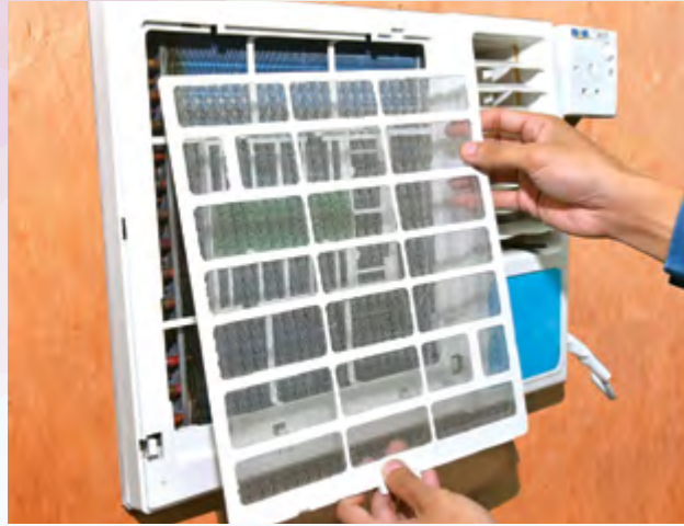
1. Buka penutup panel hadapan dan keluarkan penapis udara.
