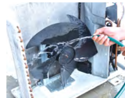
5. Bersihkan bilah kipas dengan menggunakan air.
