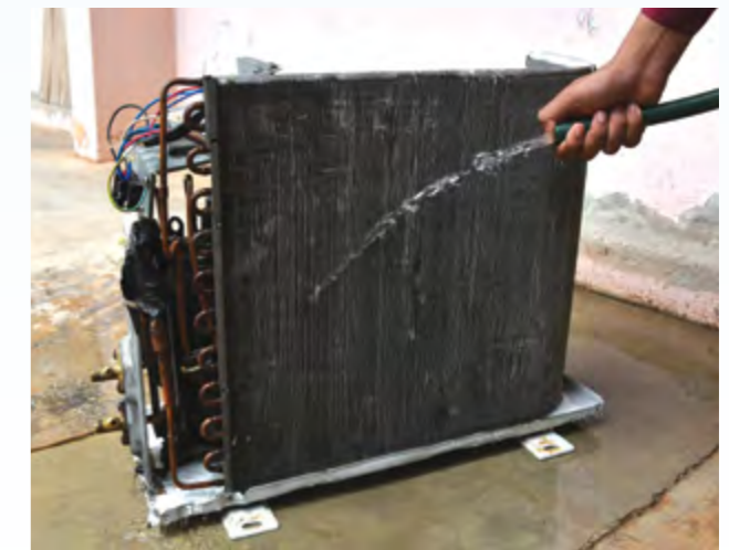
4. Bilas pemeluwap dengan menggunakan air.
