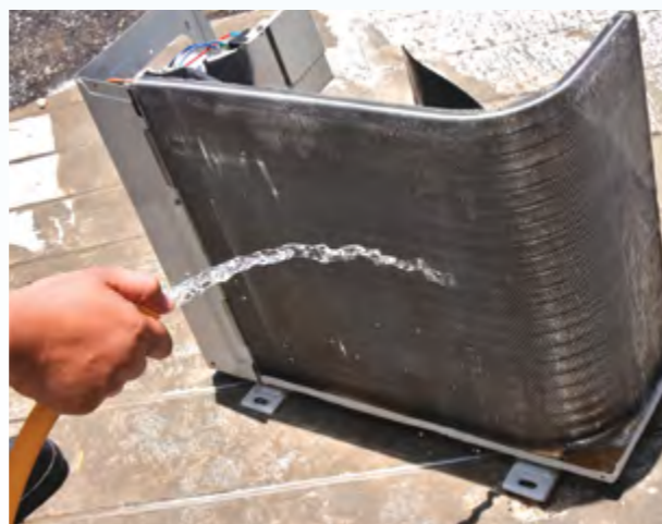
Foto 9.6 Kerja membersihkan pemeluwap
