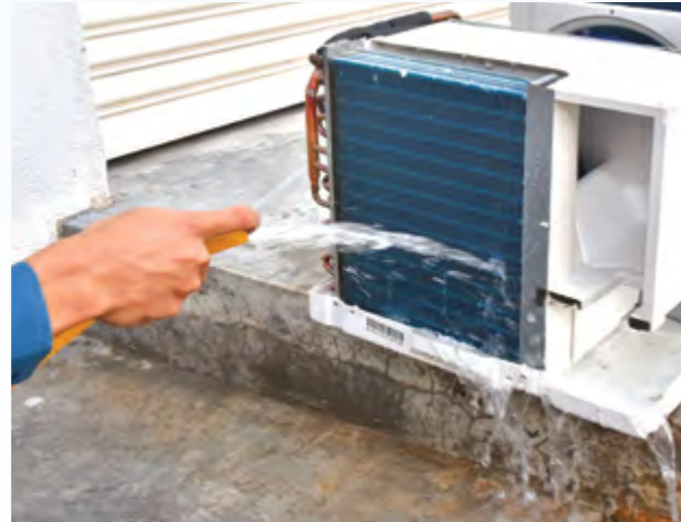
4. Semburkan penyejat dengan menggunakan air.
