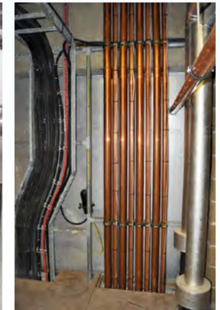
Foto 4.6 Sistem perpaipan penyaman udara jenis pengkokol
