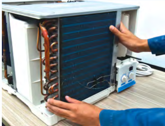
3. Turunkan unit ke bawah bagi memudahkan proses menservis penyejat dan pemeluwap.
