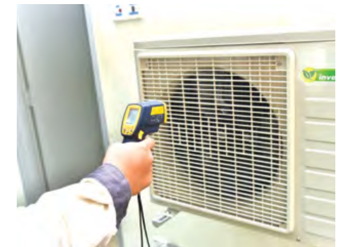
Menguji suhu unit luar
