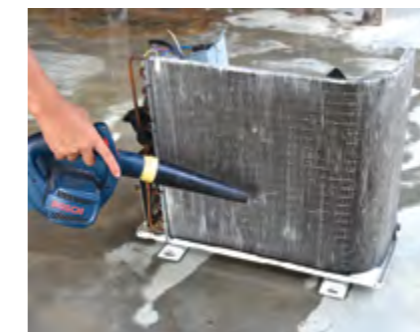
6. Keringkan unit dengan menggunakan penghembus udara.
