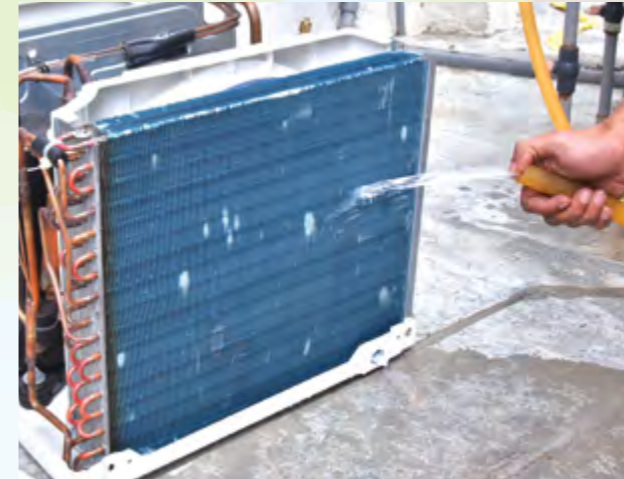
7. Semburkan pemeluwap dengan menggunakan air.
