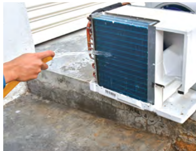
6. Bilas penyejat menggunakan air bersih dan keringkan menggunakan penghembus udara (blower).
