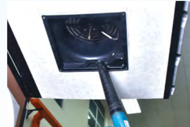
3. Bersihkan kotoran dengan menggunakan pam vakum atau kain bersih.
