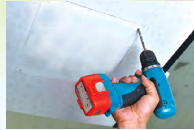
2. Proses memotong lubang pada siling dijalankan dan proses pemotongan dilakukan dengan berhati-hati.
