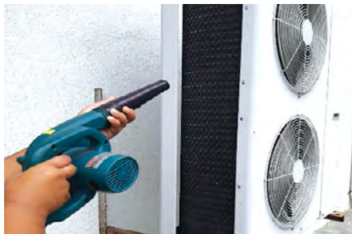
Foto 5.25 Membersihkan pemeluwap dengan menggunakan penghembus angin
