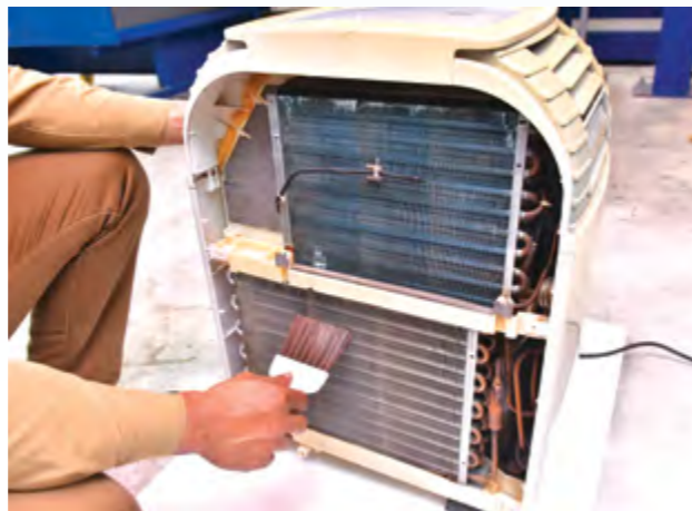
ii. Periksa gegelung penyejat dan bersihkan kotoran pada gegelung pemeluwap.
