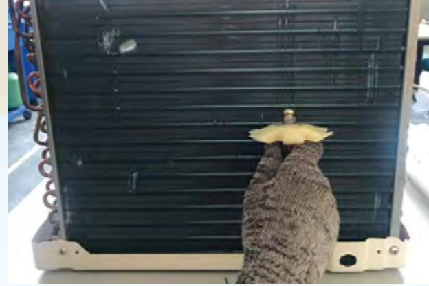
Kerja meluruskan sirip pemeluwap
