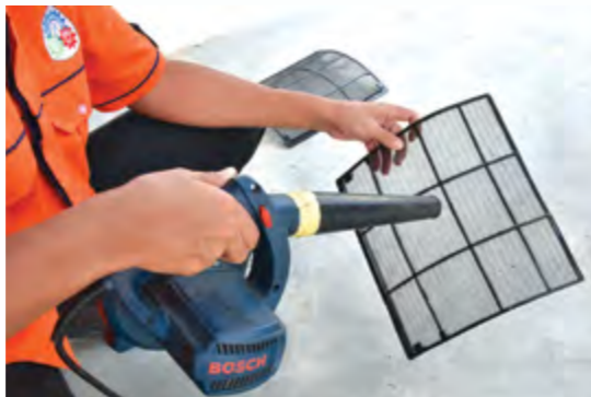
8. Keringkan unit dengan menggunakan penghembus udara.
