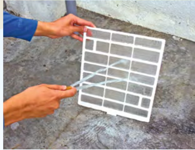
2. Bersihkan penapis udara dengan air bersih.
