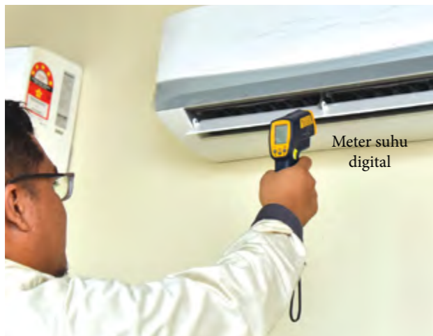
Foto 5.19 Menguji suhu pada penyejat
