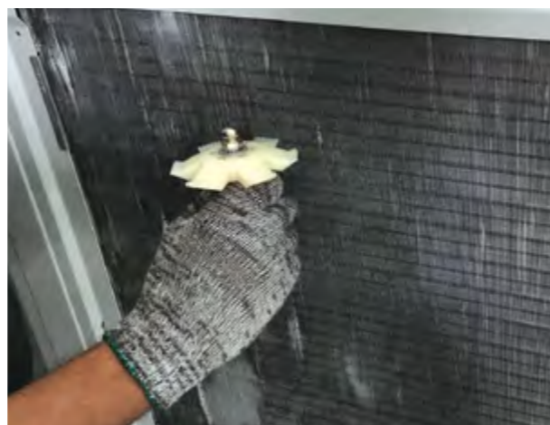
Foto 9.8 Kerja meluruskan sirip pemeluwap
