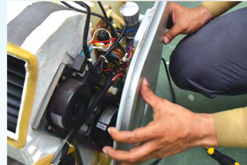
1. Buka skru pada penutup papan elektronik.
