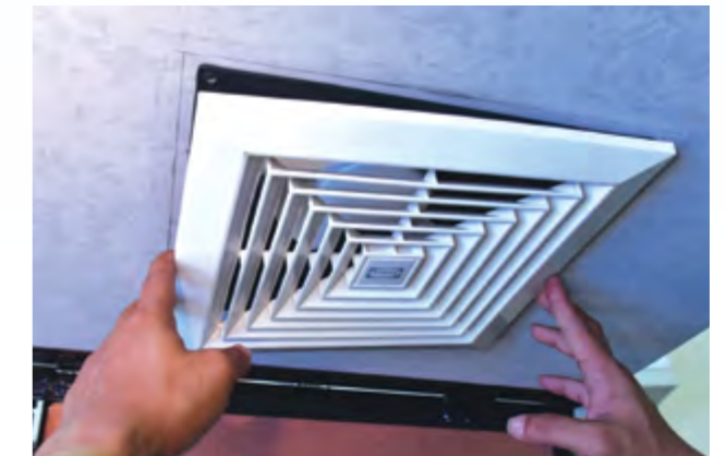
3. Bersihkan kotoran dengan menggunakan pam vakum atau kain bersih.
