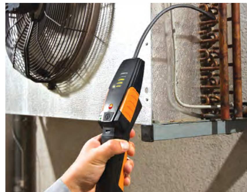
Foto 5.27 Menguji kebocoran pada pemeluwap menggunakan pengesan kebocoran elektronik
