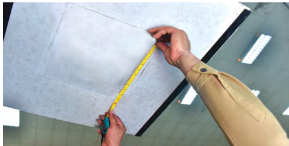
1. Membuat penandaan tempat pemasangan kipas pengudaraan pada siling mengikut saiz yang dikehendaki.
