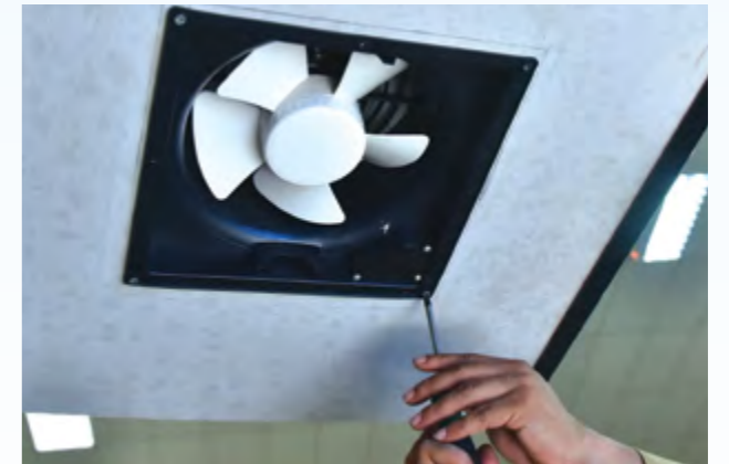
4. Pasangkan kipas pengudaraan pada siling. Ketatkan kipas dengan skru yang disediakan.
