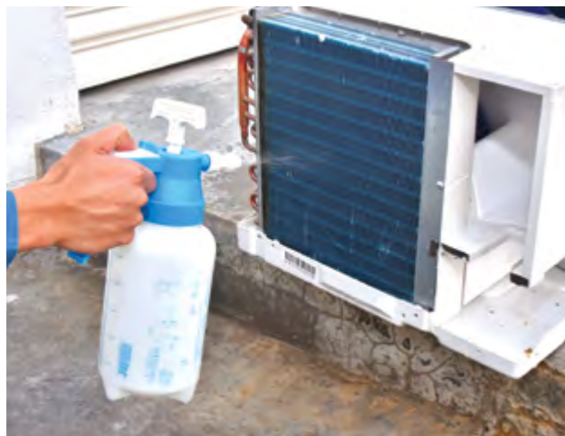
5. Semburkan bahan kimia ke permukaan penyejat dan biarkan selama 5 hingga 10 minit.
