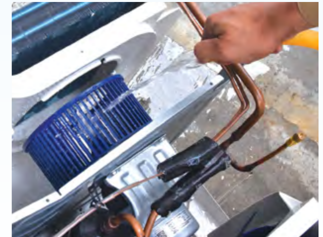
10. Bersihkan kipas penghembus dengan menggunakan air bersih.
