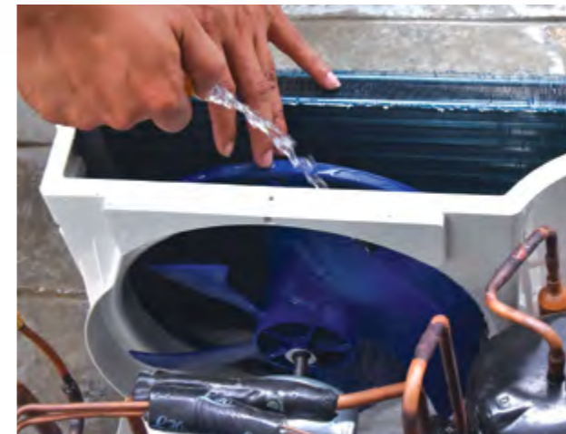
11. Bilas bilah kipas dengan menggunakan air bersih dan keringkannya dengan menggunakan penghembus udara.
