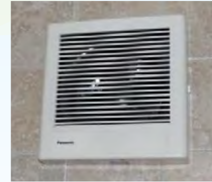
Foto 9.19 Pemasangan di dinding
