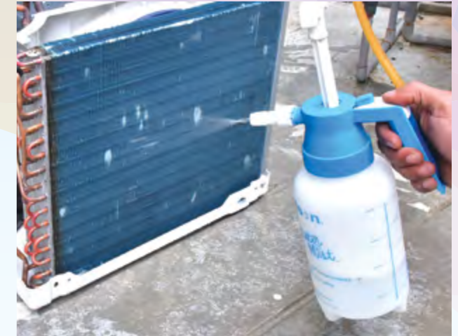
8. Semburkan bahan kimia ke permukaan pemeluwap dan biarkan selama 5 hingga 10 minit.
