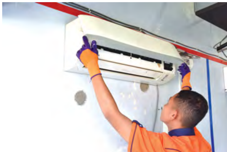
9. Setelah semua unit dikeringkan dengan sempurna, pasang semula unit seperti asal.
