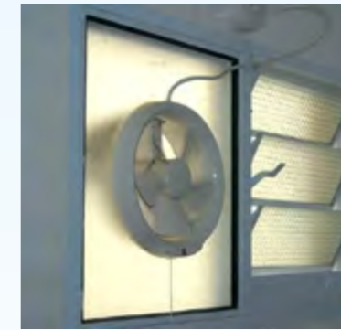
Foto 9.20 Pemasangan di tingkap
