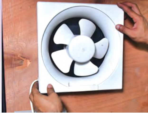
4. Pasangkan penutup kipas dan ketatkannya dengan menggunakan skru yang disediakan.
