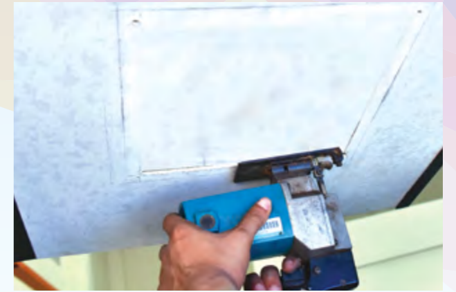
2. Proses memotong lubang pada siling dijalankan dan proses pemotongan dilakukan dengan berhati-hati.
