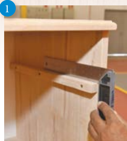
1. Menguji ketepatan sudut gelungsur laci.
