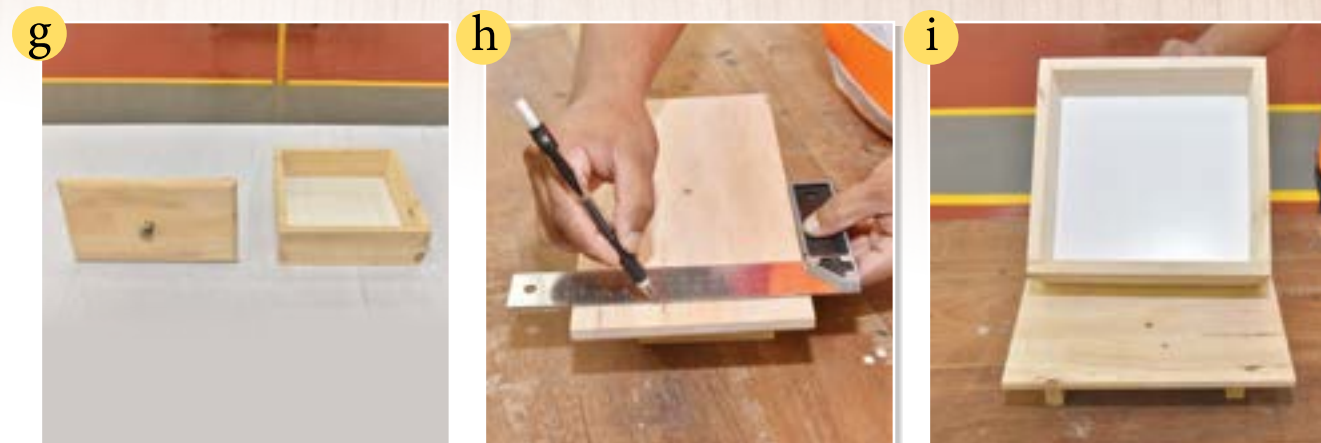
Menyedia muka laci dan kotak laci untuk dipasang.
