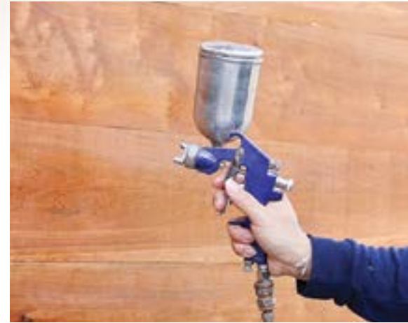
Foto 6.27 Kaedah menyembur menggunakan alat semburan
