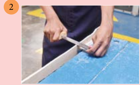
2 Kemaskan sisi templat menggunakan kikir halus
