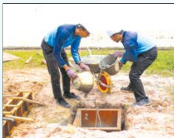
Foto 8.13 Menuang konkrit ke dalam kotak acuan asas pad
