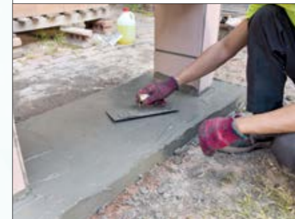
Membuat lepaan licin pada bahagian tapak kerusi.
