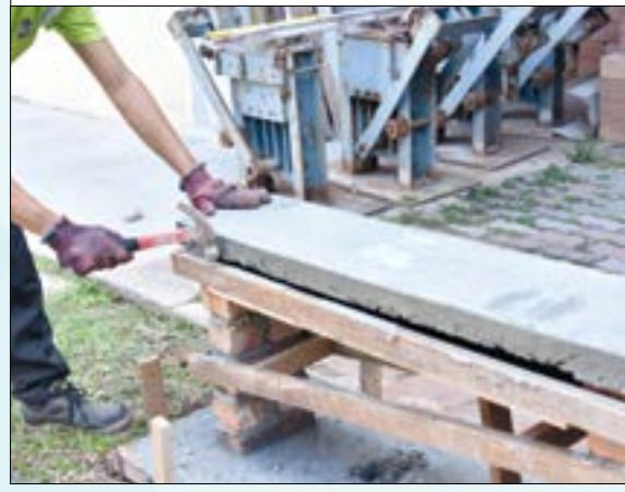
Setelah konkrit kering pada kotak acuan papak kerusi dan lantai, kotak acuan boleh ditanggalkan.
