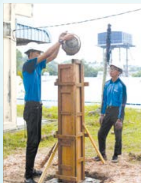
Foto 8.15 Menuang konkrit ke dalam kotak acuan tiang
