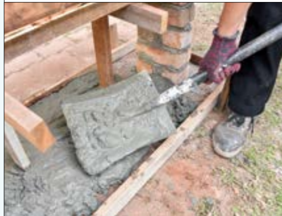
Menuang bancuhan konkrit ke kotak acuan lantai.
