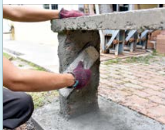
Melakukan proses lepaan pada ikatan bata tiang kerusi.
