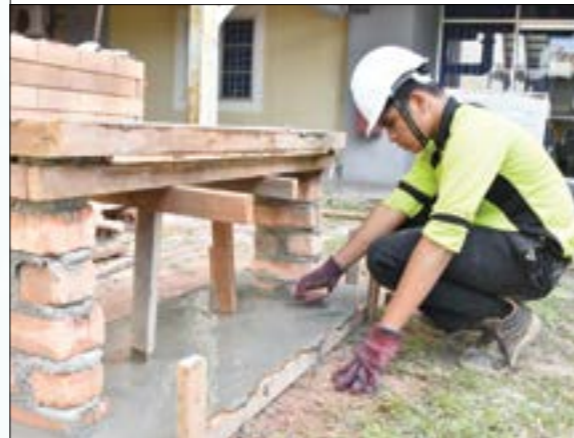
Meratakan dan memadatkan bancuhan konkrit pada kotak acuan lantai.
