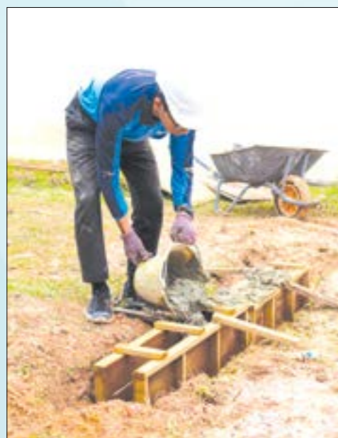
Foto 8.14 Menuang konkrit ke dalam kotak acuan rasuk
