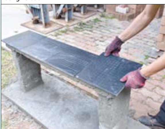
Memasang jubin pada bahagian tempat duduk dan tiang kerusi.
