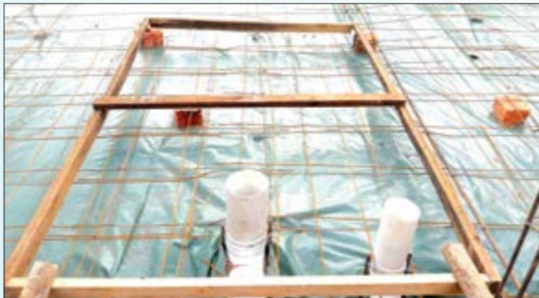
Foto 5.5 Pemasangan Kepingan Plastik ( Polyethylene )
