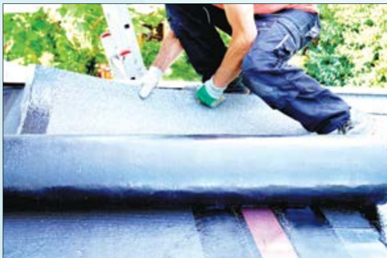
Foto 5.6 Pemasangan Lapisan Bitumen
