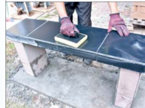
Melakukan proses kemas selepas siap pemasangan jubin.
