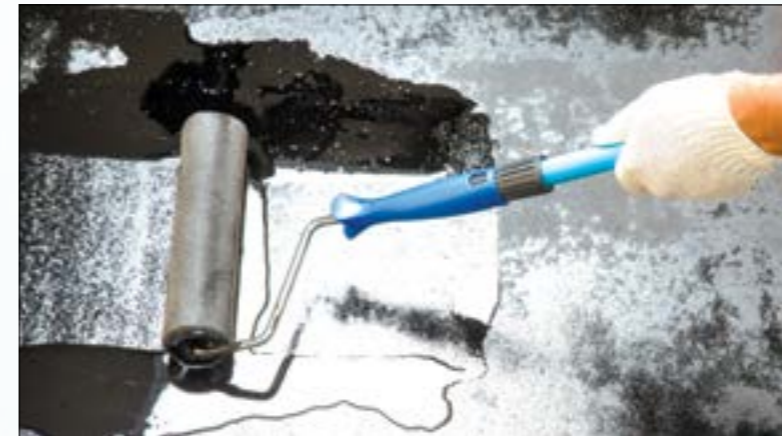
Foto 5.7 Proses Meratakan Bitumen Cair
