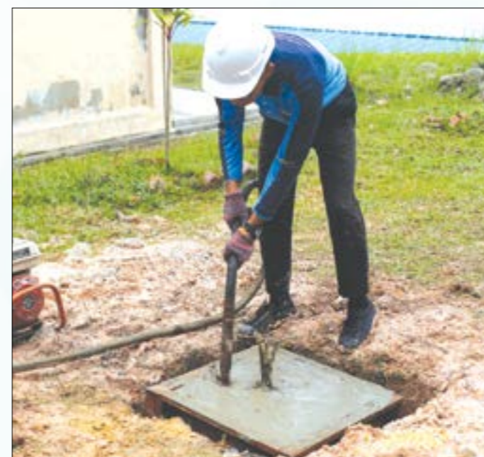
Foto 8.16 Memadatkan konkrit dalam kotak acuan asas pad menggunakan alat penggetar
