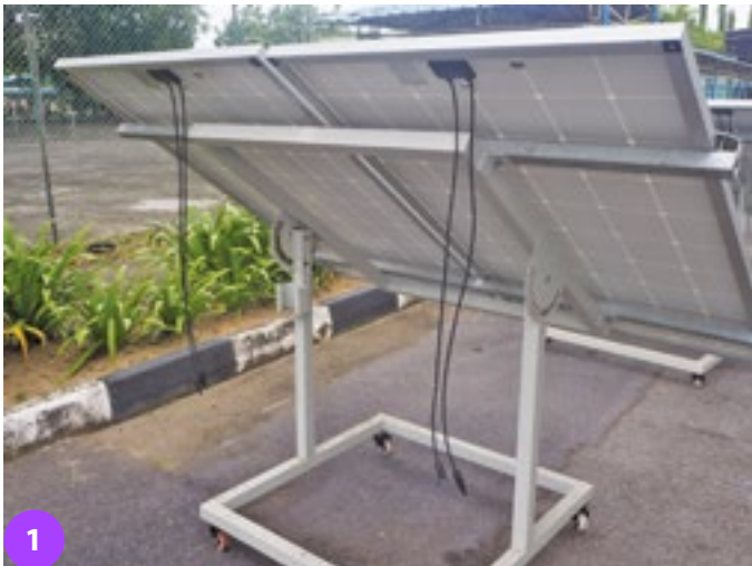
Penyediaan 2 modul panel solar (PV) bagi sambungan selari.
