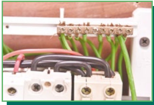
Rajah 4.5 Menunjukkan terminal bumi pada sebuah kotak agihan
