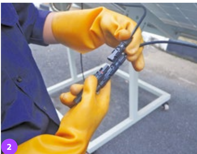
Terminal positif pada (PV1) disambungkan bersama terminal positif (PV2) dengan menggunakan penyambung MC4 (2 dalam 1).
