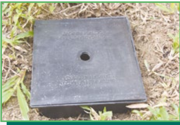
Rajah 4.6 Menunjukkan kotak bumi pada sebuah kotak agihan
