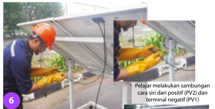
6 Pemasangan litar siri pada 2 modul solar (PV).
