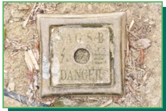
Rajah 4.6 Menunjukkan kotak bumi pada sebuah kotak agihan
