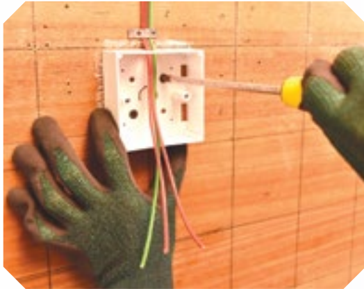
Langkah 9: Buang penambat pada hujung kabel.
