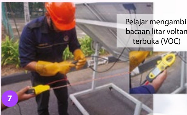
7 Clamp meter digunakan bagi mengambil bacaan (VOC) yang disambung dengan probe pada terminal positif dan negatif.
