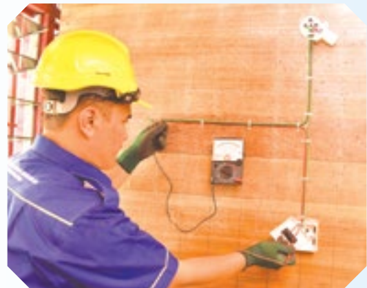
Langkah 13: Lakukan pengujian litar hidup.
