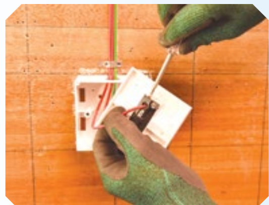
Langkah 12: Buat pengujian litar mati.
