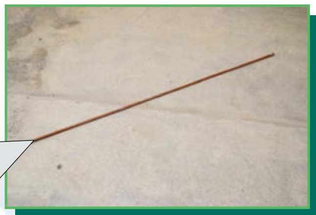
Rajah 4.7 Menunjukkan elektrod bumi pada sebuah kotak agihan
