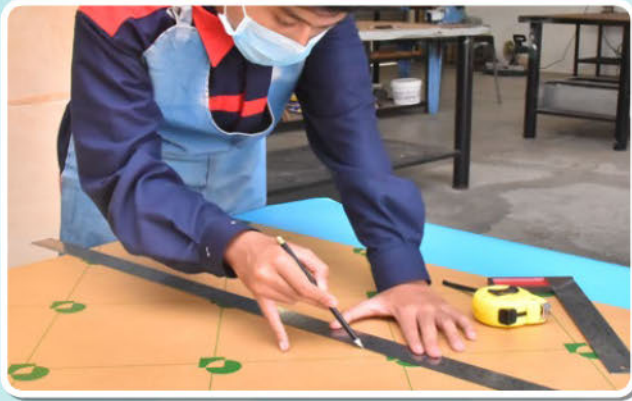
1 Mengukur dan menanda ukuran panel.
